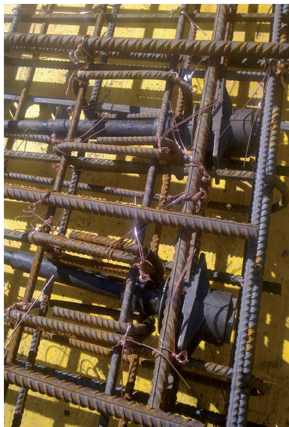
Рис.4. Вузли анкерування канатів у монолітному перекритті.
