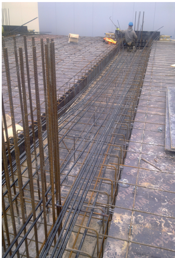
Рис.3. Встановлення канатів для постнапруження балки монолітного перекриття
