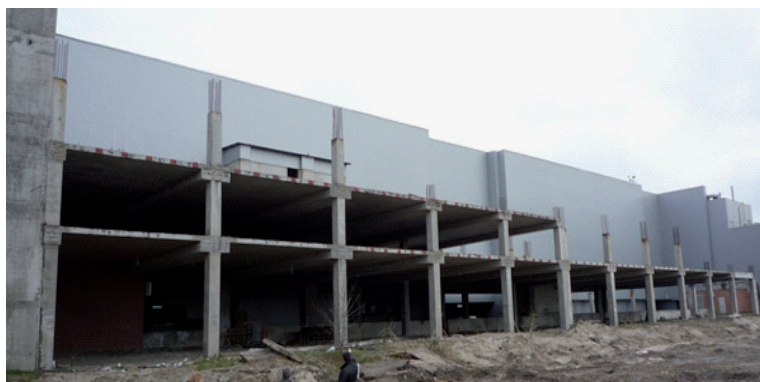
Рис.1. Будівництво паркінгу торгово-розважального центру по проспекту Генерала Ватутіна в м. Києві з постнапруженими монолітними залізобетонними перекриттями.
