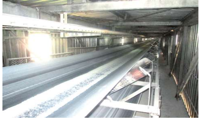
Рисунок 2 – Загальний вигляд галереї зсередини
