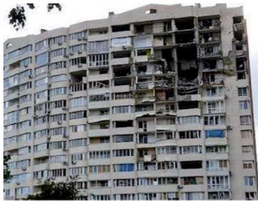
Рисунок 4 – Наслідки влучань в монолітні будівлі різними засобами ураження а) будівля в м. Чернігів; б) будівля в м. Київ
