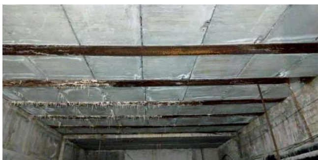
Рисунок 7 – Сліди протікання по швах між плитами перекриття тераси секції І і на стіні підвалу, вапнякові утворення
