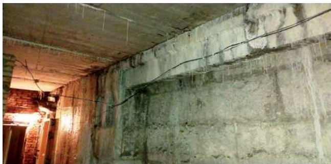
Рисунок 6 – Сліди протікання по швах між плитами перекриття тераси секції І і на стіні підвалу, вапнякові утворення
