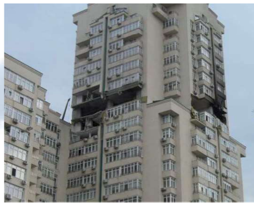
Рисунок 4 – Наслідки влучань в монолітні будівлі різними засобами ураження а) будівля в м. Чернігів; б) будівля в м. Київ
