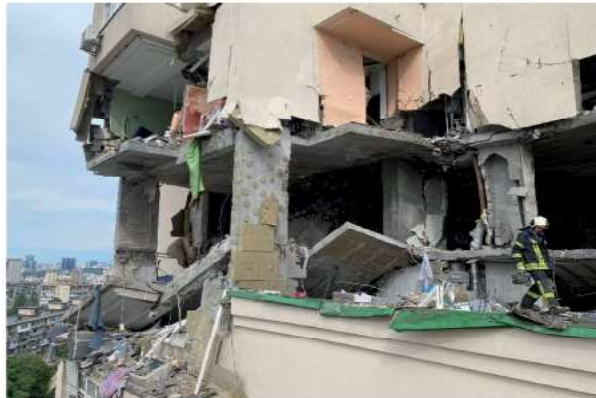
Рисунки 5 ÷ 8 – Фотофіксація руйнувань конструкцій зі значними наслідками пошкоджень
