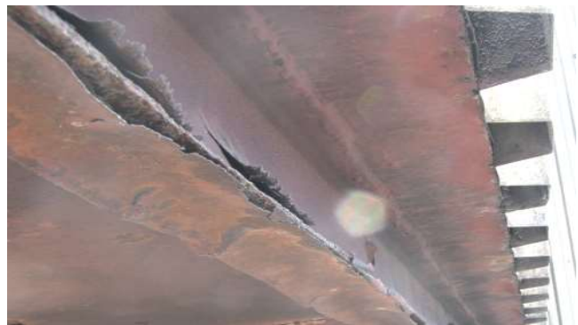
Рисунок 3 – Стан фрагменту головної повздовжньої балки днища. Виразкова корозія зовнішнього краю нижньої полицки двотавра
