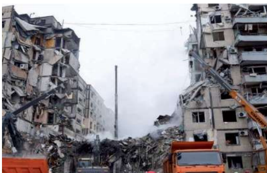
Рисунок 5 – Наслідки лавиноподібного обвалення конструкцій будівлі в м. Дніпро а) будівля на ранок після влучання; б) будівля після розбирання завалів
