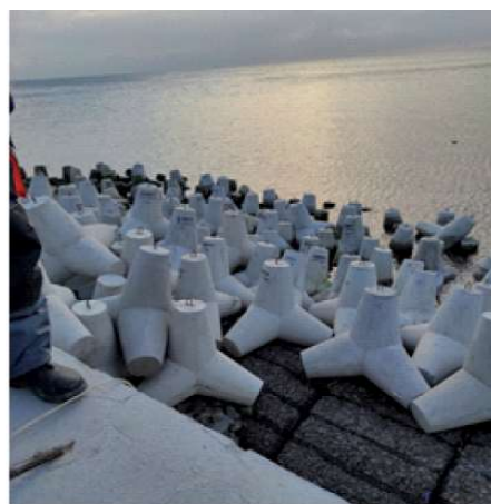
Рисунки 6 ÷ 7 – Кріплення берега акваторії Одеського порту
