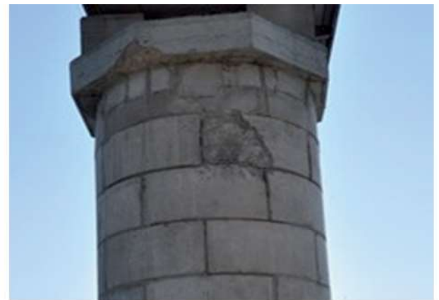
Рисунки 12÷13 – Пошкодження металевого перильного огородження, пробиття мостового полотна на прогонової будови № 3-4 та залізобетонного лицевального блоку опори № 2
