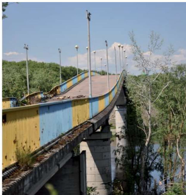
Рисунки 2 ÷ 4 – Загальні види на пішохідний міст через р. Десна в м. Чернігів. Вид на пошкодження мосту з лівого берега в бік центру міста
