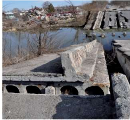
Рисунки 9 ÷ 10 – Руйнація мостової споруди внаслідок артилерійських вибухів
