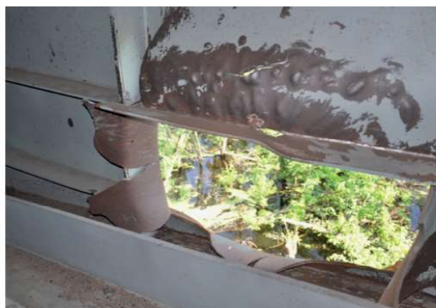
Рисунки 5 ÷ 6 – Пробиття бокового вертикального листа та поперечних ребер металевої балки мосту та бокового вертикального листа та ребер жорсткості металевої балки мосту
