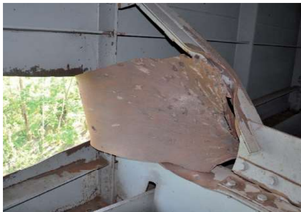
Рисунки 7 ÷ 8 – Пошкодження (пробиття) бокового вертикального листа та елементів поперечної рами жорсткості металевої балки мосту, а також бокового вертикального листа металевої балки мосту
