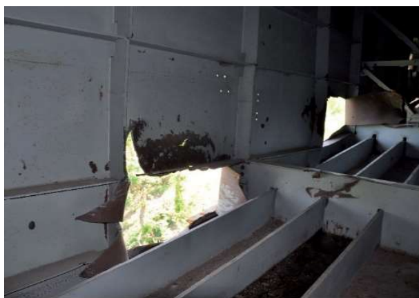
Рисунки 5 ÷ 6 – Пробиття бокового вертикального листа та поперечних ребер металевої балки мосту та бокового вертикального листа та ребер жорсткості металевої балки мосту
