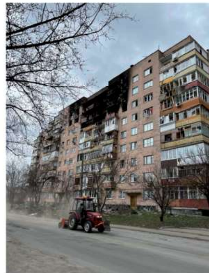
Рисунок 6 – Пошкодження житлових будинків від танкових снарядів
