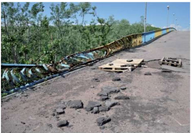
Рисунки 12÷13 – Пошкодження металевого перильного огородження, пробиття мостового полотна на прогонової будови № 3-4 та залізобетонного лицевального блоку опори № 2
