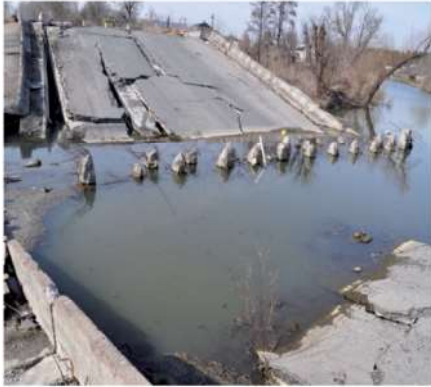
Рисунки 9 ÷ 10 – Руйнація мостової споруди внаслідок артилерійських вибухів
