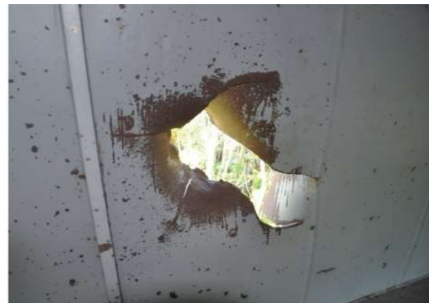
Рисунки 7 ÷ 8 – Пошкодження (пробиття) бокового вертикального листа та елементів поперечної рами жорсткості металевої балки мосту, а також бокового вертикального листа металевої балки мосту
