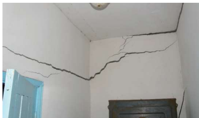
Рисунок 5 – Характерний вигляд тріщин в перегородках безпідвальних приміщень західного блоку через просідання ґрунтів основи
