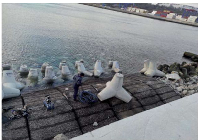
Рисунки 6 ÷ 7 – Кріплення берега акваторії Одеського порту
