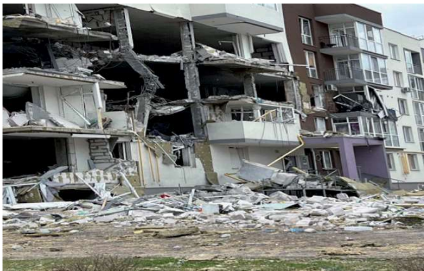
Рисунок 6 – Пошкодження житлових будинків від танкових снарядів
