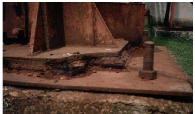
Рисунок 3 – Дефекти опорних вузлів: а – щогли; б – вежі
