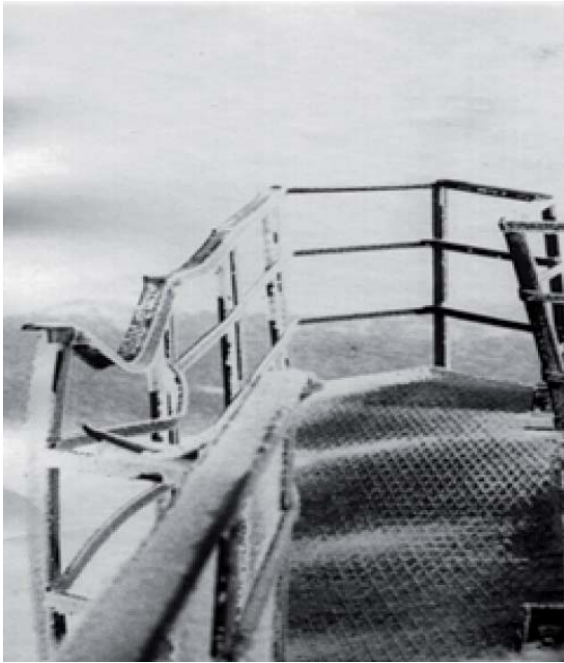
Рисунок 5 – Руйнування конструктивних елементів щогли після падіння крижаної бомби: а – майданчик обслуговування; б – хвилевід і залізобетонне покриття технічної споруди
