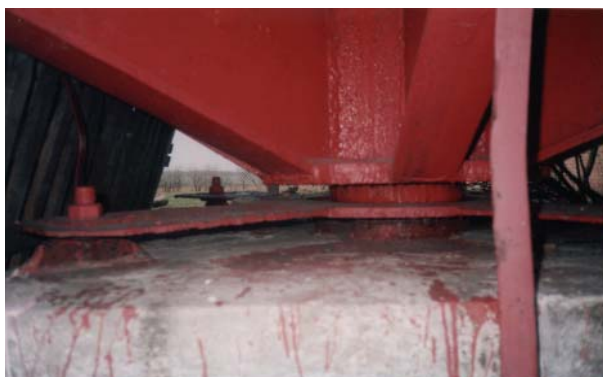
Рисунок 3 – Дефекти опорних вузлів: а – щогли; б – вежі
