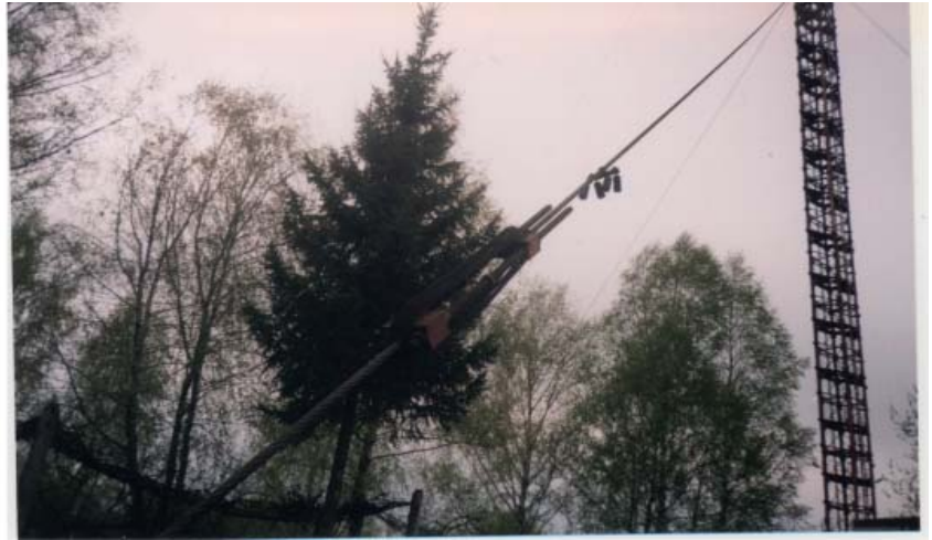
Рисунок 2 – Дефектні нерухомі траверси стяжних муфт
