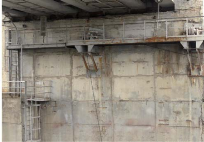
Рисунок 14 – Суцільна корозія металевих тангенціальних опорних частин та пошкодження захисного шару, локальне оголення арматури та корозія арматури (опора № 2)
