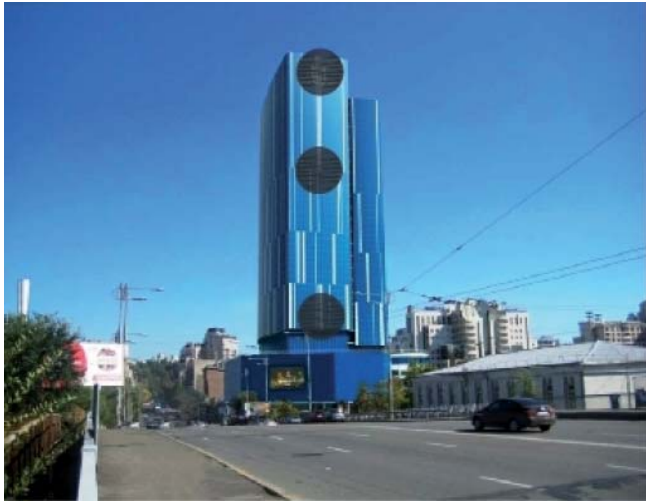
Рисунок 11 – Відбивачі на південно-західному фасаді будівлі
