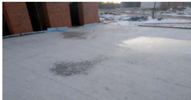
Рисунок 7 – Забетонована конструкція на 5 добу тверднення
