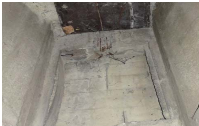
Рисунок 13 – Пошкодження захисного шару бетону у вузлі діафрагми та сколи бетону у розтягнутій зоні з оголенням арматури, корозія арматури, сліди замокання з вилугуванням бетону на торцевих частинах плити мостового полотна
