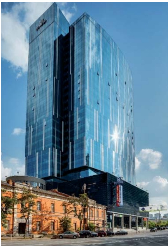
Рисунок 6 – Загальний вигляд будівлі бізнес-центру «101 Tower»
