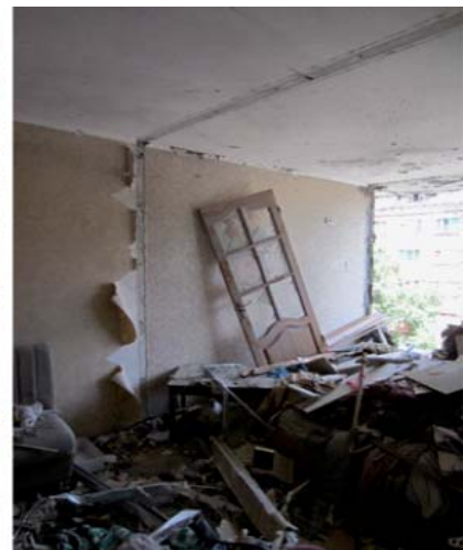
Рисунок 3 – Локальні пошкодження житлового будинку по вул. Толстого, 142
