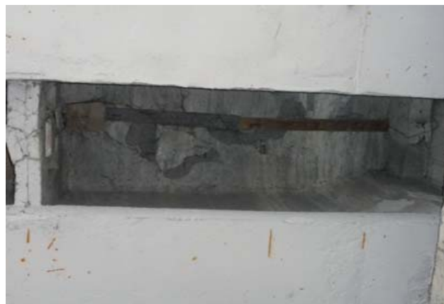
Рисунок 6 – Сколювання бетону із оголенням арматури, корозія арматури (прогін № 1-2)
