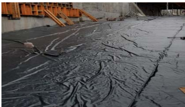
Рисунок 11 – Забетонована конструкція на 2 добу тверднення
