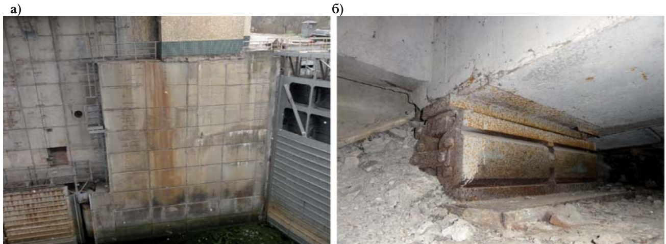
Рисунок 12 – Монолітні залізобетонні опори
