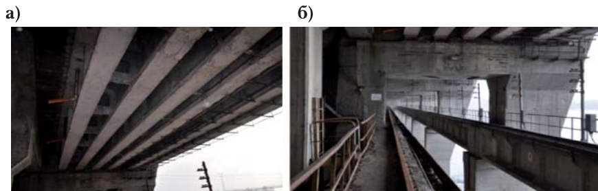
Рисунок 3 – Вид знизу: а) на прогони № 1-2 та б) монолітні П-подібні залізобетонні опори, суміщені з биками будівлі ГЕС
