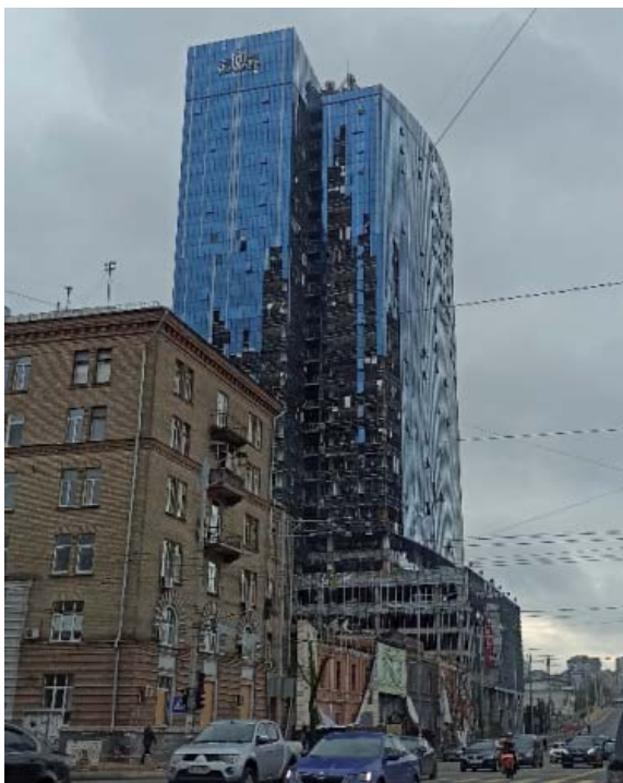
Рисунок 13 – Стан будівлі бізнес-центру «101 Tower» на осінь 2023 р.
