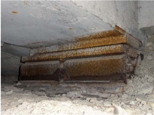
Рисунок 14 – Суцільна корозія металевих тангенціальних опорних частин та пошкодження захисного шару, локальне оголення арматури та корозія арматури (опора № 2)
