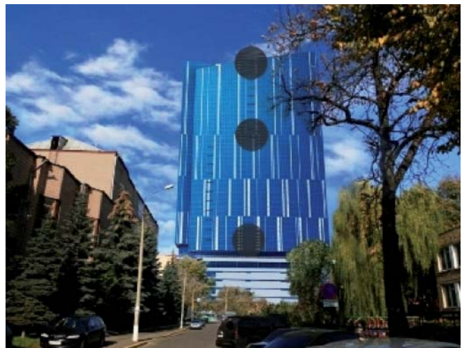
Рисунок 12 – Відбивачі на південно-східному фасаді будівлі
