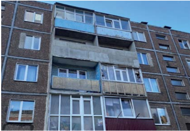
Рисунок 4 – Відновлення локальних пошкоджень житлового будинку по вул. Толстого, 142
