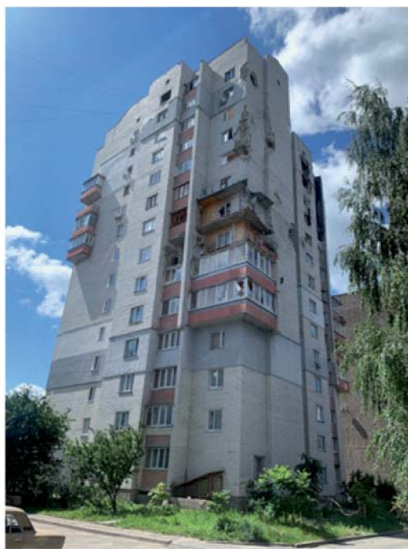
Рисунок 13 – Часткові пошкодження та руйнування конструкцій житлового будинку по вул. Генерала Белова, 27
