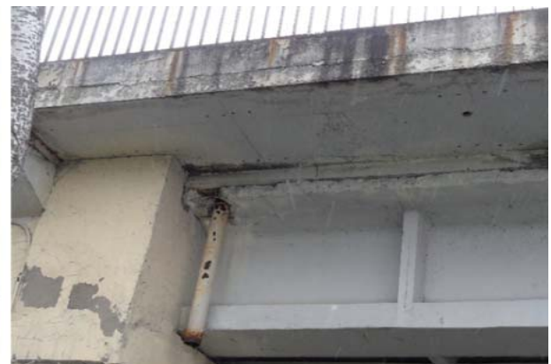
Рисунок 13 – Пошкодження захисного шару бетону у вузлі діафрагми та сколи бетону у розтягнутій зоні з оголенням арматури, корозія арматури, сліди замокання з вилугуванням бетону на торцевих частинах плити мостового полотна
