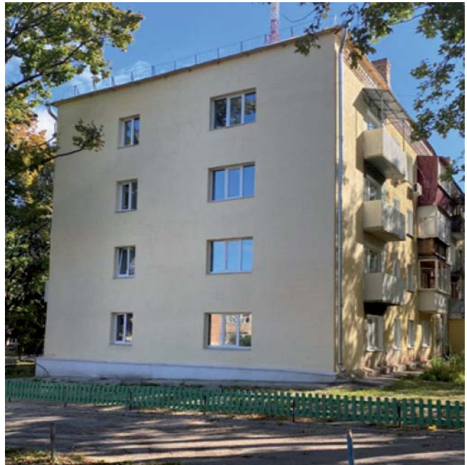
Рисунок 10 – Відновлення часткових пошкоджень житлового будинку по вул. Ремісника, 55а
