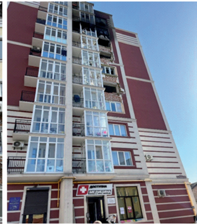
Рисунок 5 – Наслідки пожежі та руйнування фасадної теплоізоляції після вибухів на мансардному (а) та горішньому (б) поверхах житлових будинків
