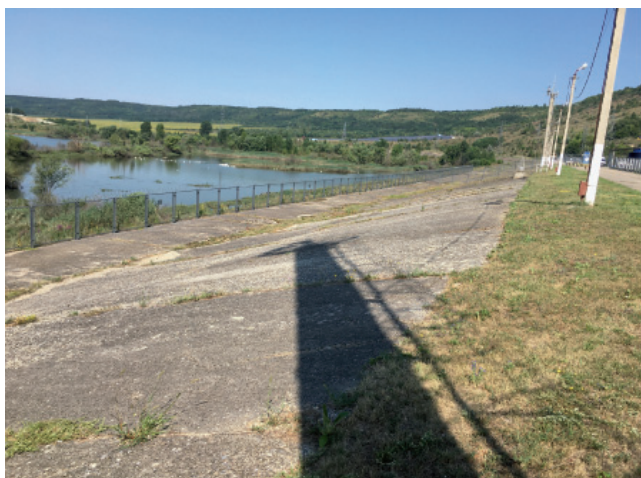
Рисунок 6 – Кріплення верхового укосу лівобережної греблі Дністровської ГЕС-2 на буферному водосховищі монолітними залізобетонними плитами
