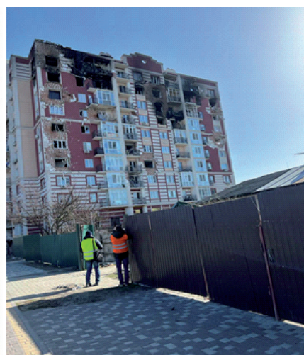
Рисунок 2 – Вид фасаду житлового будинку після його розстрілу з російських (а) броньованих машин та (б) танків
