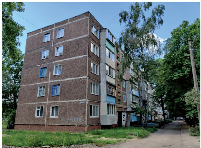
Рисунок 1 – Фрагмент дворового фасаду панельного житлового будинку серії 1-464А
