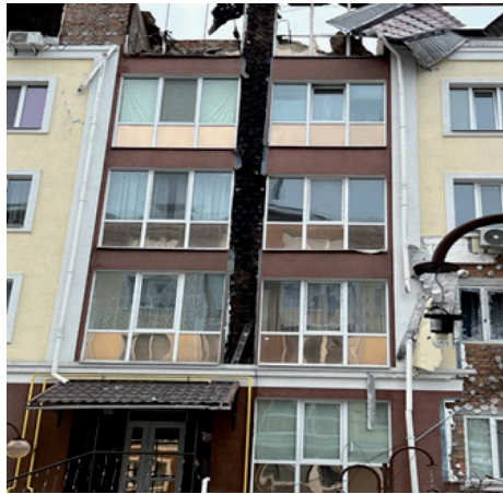
Рисунок 5 – Наслідки пожежі та руйнування фасадної теплоізоляції після вибухів на мансардному (а) та горішньому (б) поверхах житлових будинків
