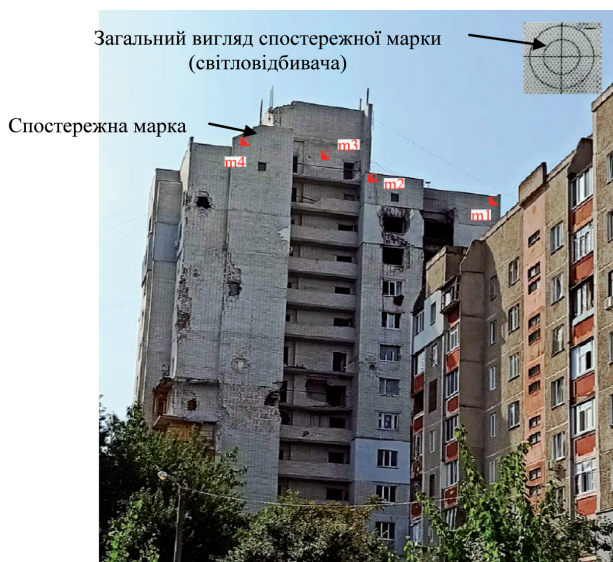
Рисунок 3 – Приклад встановлення спостережних марок по вул. Генерала Белова, 27
