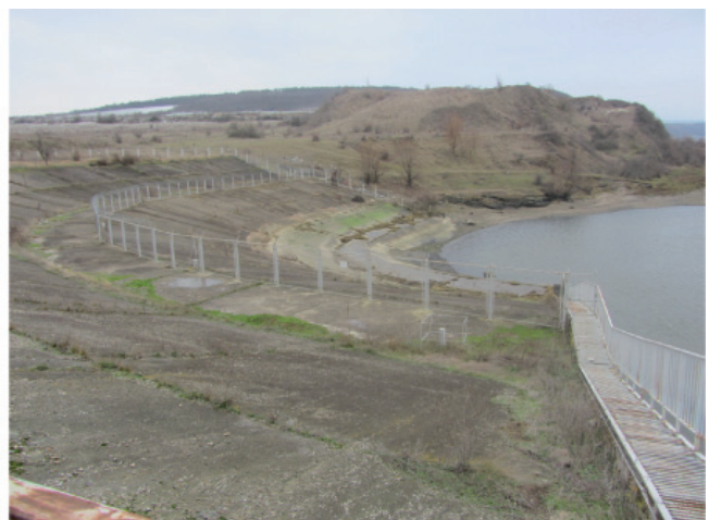
Рисунок 6 – Кріплення верхового укосу лівобережної греблі Дністровської ГЕС-2 на буферному водосховищі монолітними залізобетонними плитами
