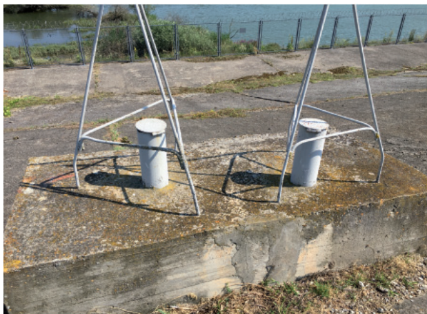
Рисунок 7 – Опускні п'єзометри на лівобережній греблі з ґрунтових матеріалів Дністровської ГЕС-2 на буферному водосховищі
