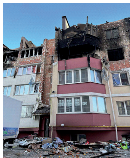
Рисунок 3 – Вид двох секцій чотириповерхового житлового будинку після вибуху на мансардному поверсі
