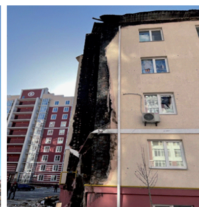
Рисунок 4 – Наслідки для фасадної системи після виникнення пожежі від вибуху на покрівлі будинків
