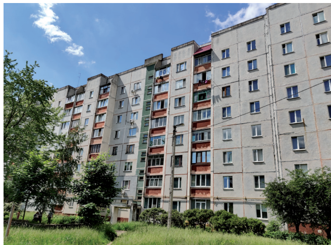
Рисунок 2 – Фрагмент дворового фасаду панельного житлового будинку серії АПВС ЧН-94
