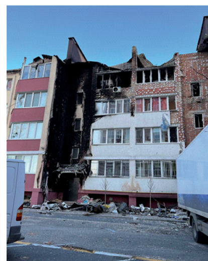
Рисунок 3 – Вид двох секцій чотириповерхового житлового будинку після вибуху на мансардному поверсі
