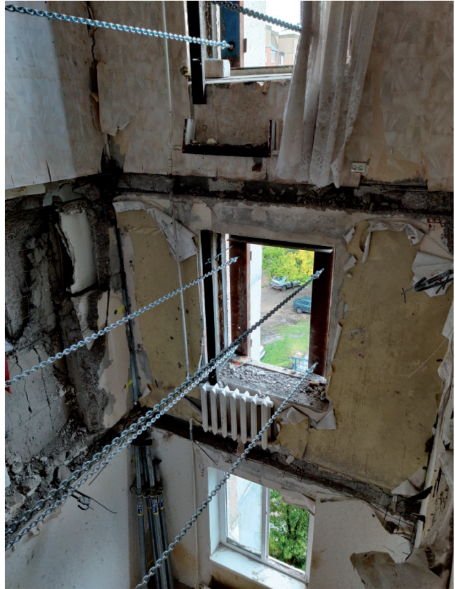
Рисунок 6 – Закріплення фасадних панелей для демонтажу зруйнованих перекриттів
