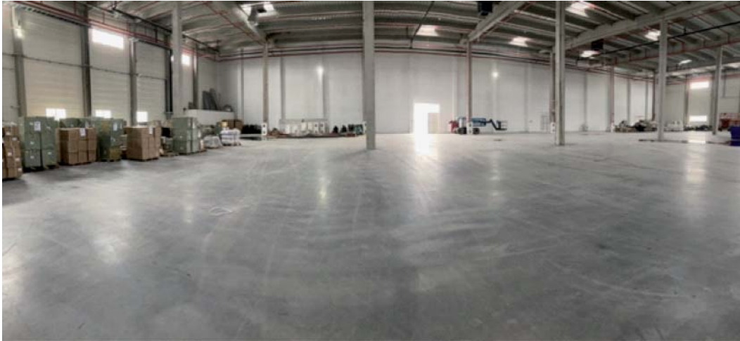
Рисунок 10 – Логістичний склад, виконаний по технології Seamless Floor Technology, м. Вінниця
