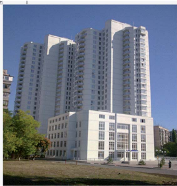
Рисунок 2.8 – Каркасный 24-х поверховий житловий будинок по вул.Акад. Глушка, 4 (м. Одеса)
