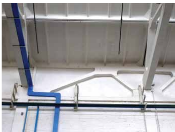
Рис.11. Вертикальні тріщини шириною до 3мм в прольоті, прогин – 40 мм, плита в осях „8-9” біля осі „Б” – аварійна по одному поздовжньому ребру.
