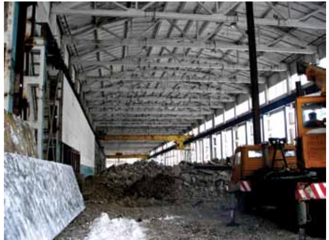
Рис.2. Блок в осях „Б-А”/„6-32” в процесі реконструкції корпусу фабрики.
