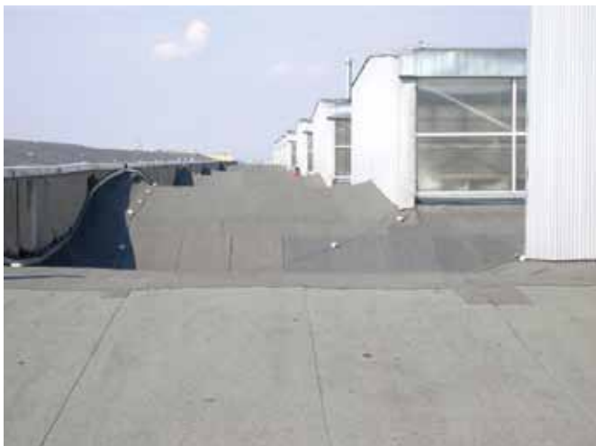
Рис.4. Загальний вид на покрівлю в осях „6-7”/„А-А”, після реконструкції.
