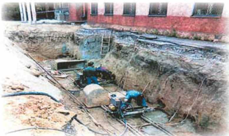
Рис.3. Усунення наднормативних кренів будинку шляхом горизонтальної підробки ґрунтової основи під подовою фундамента.
