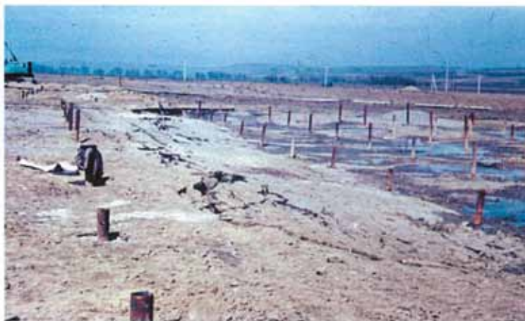
Рис.2. Осідання ущільнених гідровибухом ґрунтів.
