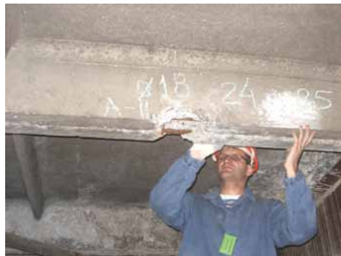
Рис.5. В процесі визначення технічного стану плит покриття суміщеного даху виробничого корпусу.
