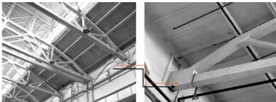
Рис.14. Підкрюквяні ферми прольотом 12 м, що вмуровані в цегляний мур протипожежних стін.
