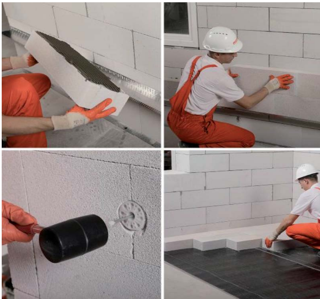
Рисунок 4 – Фрагменти виконання утеплення стін, перекриття і підлоги з використанням теплоізоляційного автоклавного газобетону AEROC Energy
