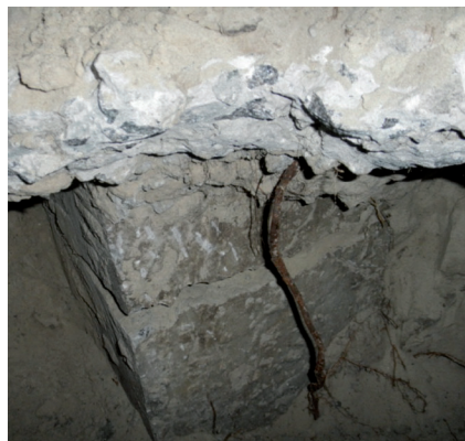
Рисунок 3 – Вигляд палі у ростверку з шурфу (а), дослідження армування (б) і контроль довжини палі (в)
