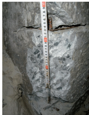
Рисунок 3 – Вигляд палі у ростверку з шурфу (а), дослідження армування (б) і контроль довжини палі (в)
