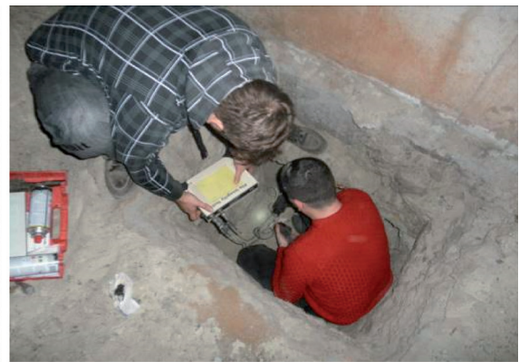
Рисунок 3 – Вигляд палі у ростверку з шурфу (а), дослідження армування (б) і контроль довжини палі (в)
