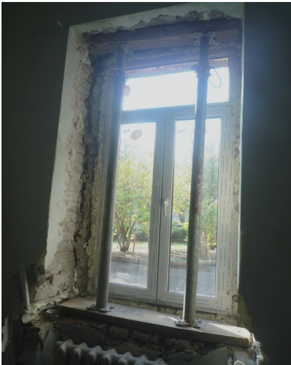
Рисунок 3 – Поздовжній розкол простінку та надвіконної частини стіни
