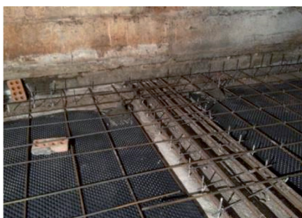
Рисунок 10 – Посилення фундаментів будівлі: а – відривання траншей та бетонування поперечних балок жорсткості між ростверками повздовжніх несучих стін і під ростверками поперечних стін сходових кліток; б, в, г – улаштування балок посилення під ростверки на перетині повздовжніх і поперечних стін; д – армування та бетонування верхньої плити посилення; е – вигляд підвалу після завершення робіт
