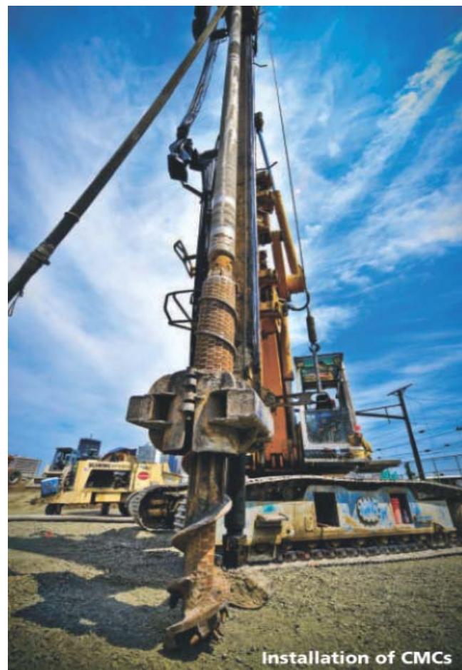
Рисунок 1 – Шнек, який використовують, при створенні палей за технологією «СМС»
