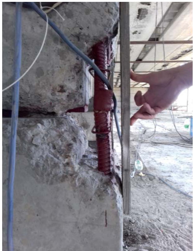
Рисунок 2 – Відхилення площини арматурних випусків від вертикальної площини
