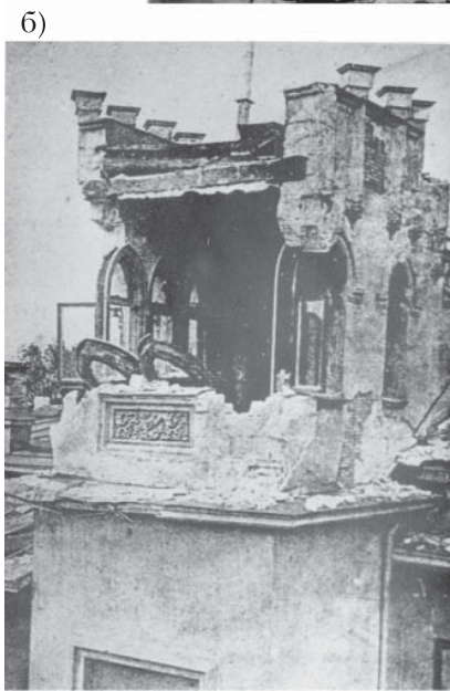
Рисунок 1 – Повреждения зданий в Ялте при землетрясении 11-12 сентября 1927 г.: а – по ул. Боткинская, 2; б – дача Чингиза также по ул. Боткинской; в – Ласточкино гнездо на мысе Ай-Тодор (фото из архива Госстроя Украинской ССР)
