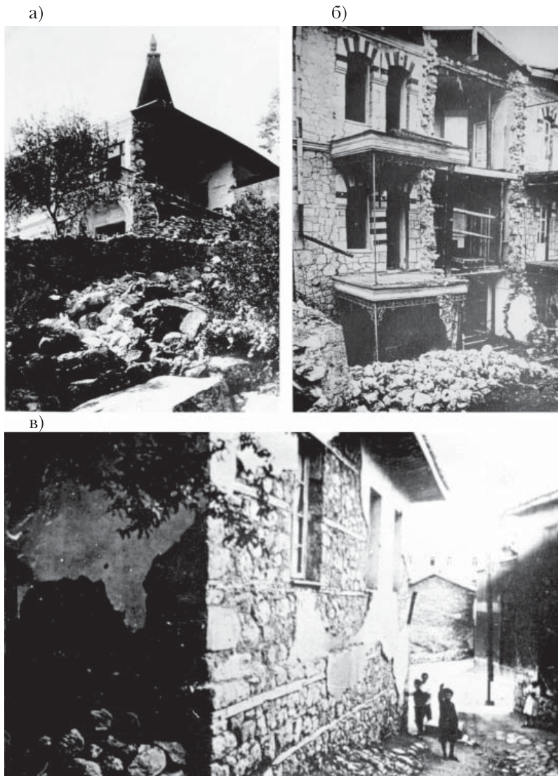
Рисунок 2 – Разрушения зданий при землетрясении 11-12 сентября 1927 г.: а- дача химиков в Рабочем уголке, Алушта; б – дача Б. Смуровой, Алупка; в – одноэтажный дом в Ялте по ул. Елизаветинской (фото из архива Госстроя Украинской СССР)
