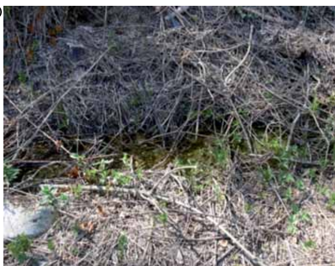
Рисунок 4 – Загальний вигляд ділянок схилу: а) локальні прояви зсувної активності; б) замочування ґрунтів схилу через вклинювання на поверхню джерел; в) витоків з водогінних комунікацій (заболочування)
