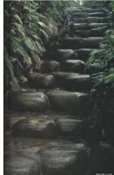
Рисунок 7 – На А), Аа), Б), Бб), В), Вв) наведено поперечні перерізи та фотографії різних типів доріжок на території «Японського саду». Вони всі виконані у відповідності до принципів «зеленого будівництва» в геотехніці та служать локальними стабілізуючими геотехнічними спорудами окремих зсувонебезпечних ділянок на поверхні головного зсуву №75 «Чукурлар-східний»
