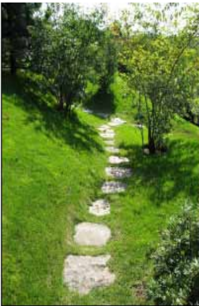
Рисунок 7 – На А), Аа), Б), Бб), В), Вв) наведено поперечні перерізи та фотографії різних типів доріжок на території «Японського саду». Вони всі виконані у відповідності до принципів «зеленого будівництва» в геотехніці та служать локальними стабілізуючими геотехнічними спорудами окремих зсувонебезпечних ділянок на поверхні головного зсуву №75 «Чукурлар-східний»
