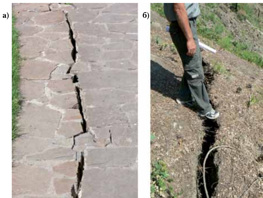
Рисунок 3 – Локальні прояви зсувної активності на схилі: а) тріщини відриву на пішохідних доріжках; б) тріщини відриву на локальних ділянках схилу
