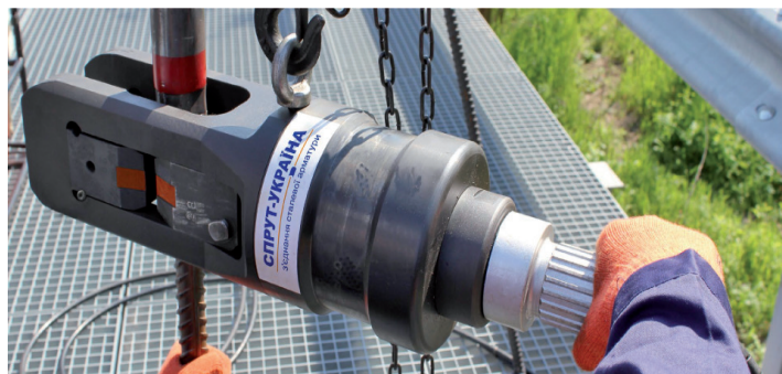
Рисунок 6 – Процесс монтажа обжимных соединений Спрут
