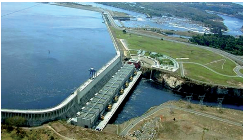
Рисунок 2 – Плотина Масagua Dam (Венесуэлла)
