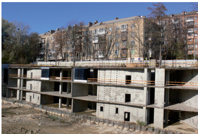
Рис. 10 Конструкції каркасу етажерки стилюбату.
