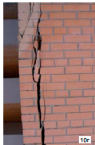
Рис. 2. Напряжения в облицовке из кирпича керамического и вызванные ими трещины
