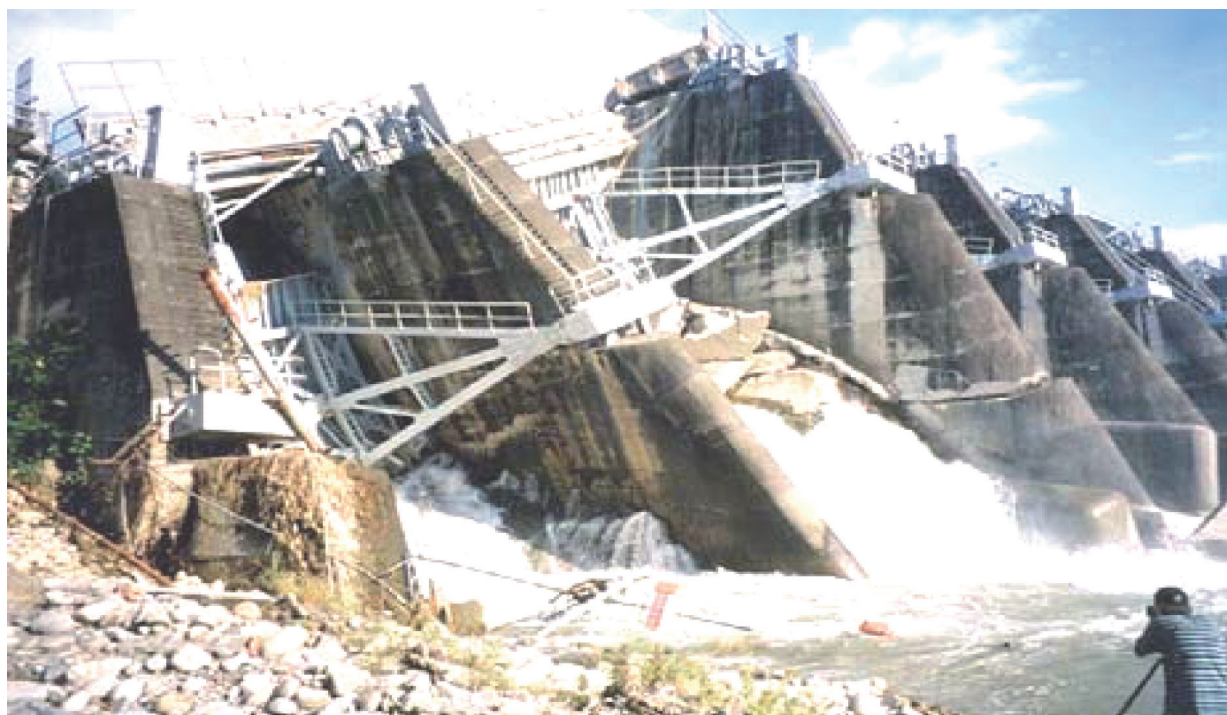
Рис. 4. Аварія на греблі Шіх Канг під час землетрусу, (Тайвань), висота 25 м, 1999 р.
