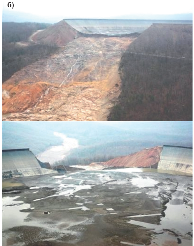
Рис. 5. Верховий басейн ГАЕС Таум Саук (США, 2005 р.): до аварії (а) та після (б)
