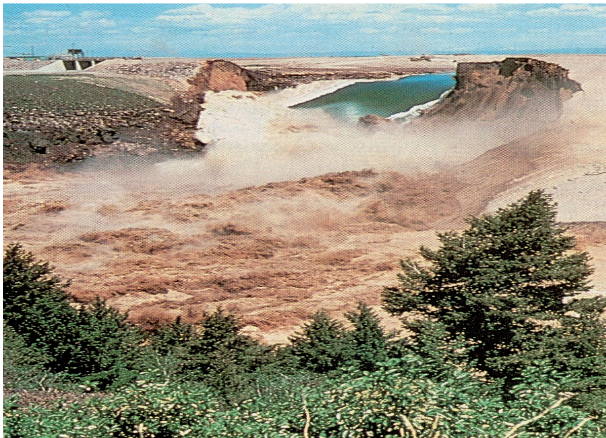
Рис. 3. Руйнування греблі Тетон (США) в 1976 р., висота 93 м, загинуло 11 осіб.
