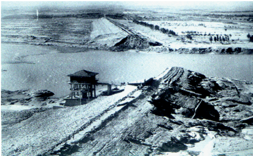
Рис. 2. Аварія на греблі Баньцяо, (Китай), 1975 р., висота греблі 118 м, загинуло біля 26 тис. людей, 145 тис. померло внаслідок голоду й епідемії, зруйновано 5 960 000 будинків, постраждало майже 11 млн. осіб
