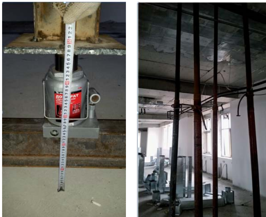
Рис. 6. Общий вид домкрата со стойкой и временных опор
