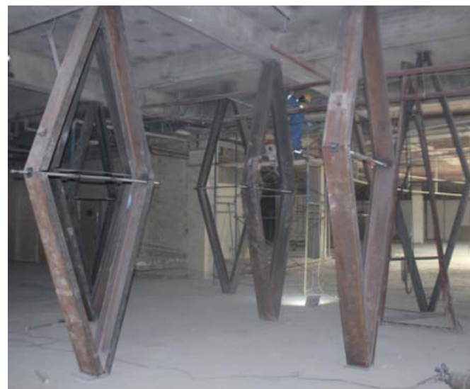
Рис. 2. Вид телескопических стоек для подъема перекрытия
