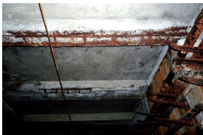
Рис. 6. Сколений захисний шар бетону з оголенням і корозією арматури плит перекриття
