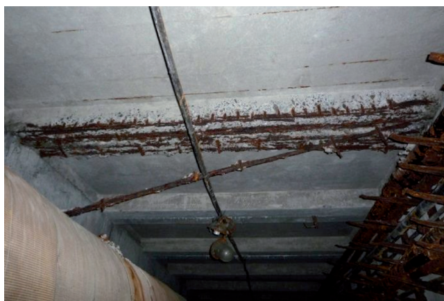
Рис. 6. Сколений захисний шар бетону з оголенням і корозією арматури плит перекриття
