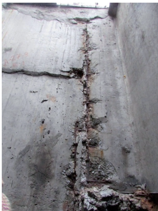
Рис. 7. Тріщина по стику стінової панелі і короба із зруйнованим захисним шаром бетону, оголеною і прокородованою арматурою (а); сколеним захисним шаром бетону, оголеною і прокородованою арматурою стінок залізобетонних блоків (б) витяжної шахти № 7
