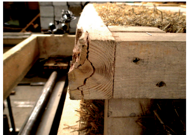
Рис.4. Дефекти панелі перекриття ПП-2
