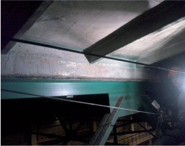
Рис.5. Впровадження системи Ruredil X Mesh GOLD на Полтавському ГЗ.
