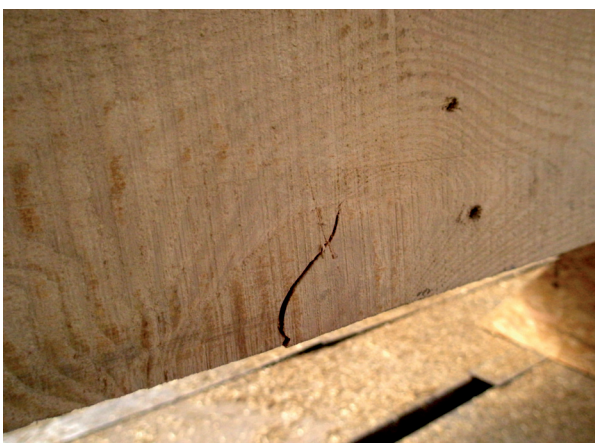
Рис.4. Дефекти панелі перекриття ПП-2
