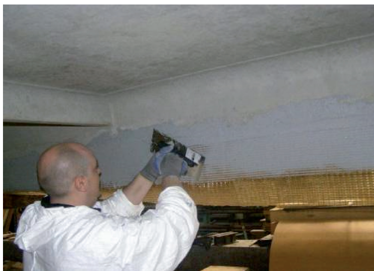
Рис.3. Нанесення підсилюючої сітки Ruredil.
