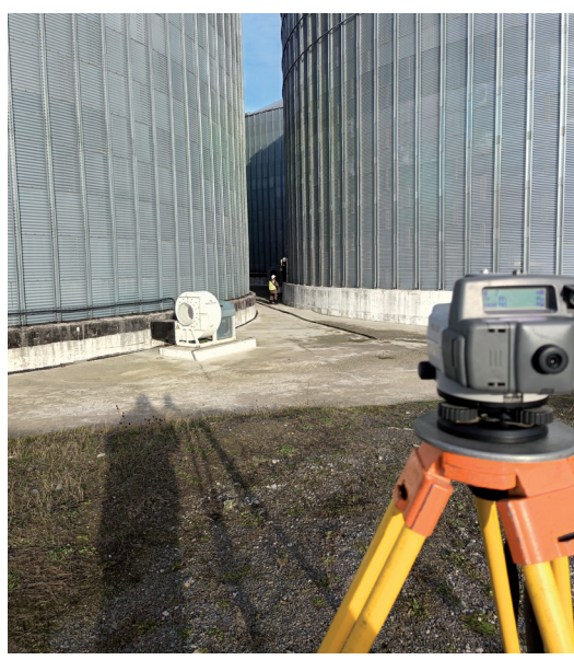
Рисунок 14 – Геометричне нівелювання закладних фундаменту
