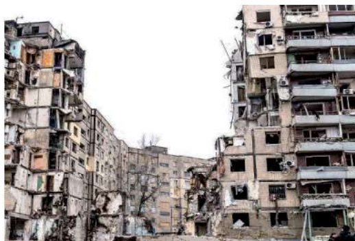
Рисунок 5 – Наслідки лавиноподібного обвалення конструкцій будівлі в м. Дніпро а) будівля на ранок після влучання; б) будівля після розбирання завалів
