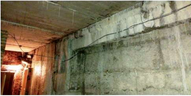
Рисунок 6 – Сліди протікання по швах між плитами перекриття тераси секції I і на стіні підвалу, вапнякові утворення
