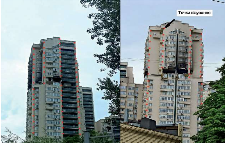
Рисунок 9 – Схема візування точок для визначення відхилень від вертикалі
