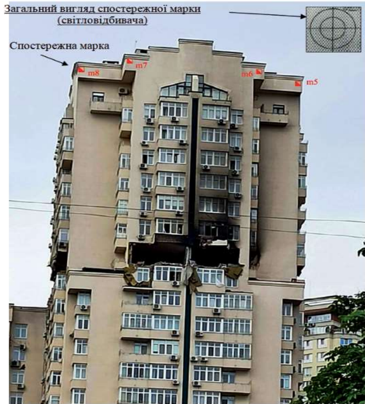
Рисунок 13 – Місця встановлення спостережних марок (світловідбивачів) на вертикальних конструкціях будівлі
