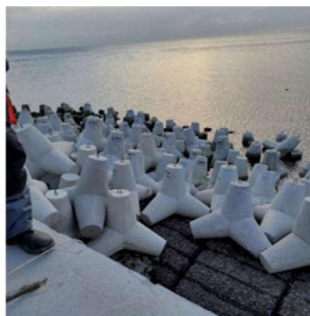
Рисунки 6 ÷ 7 – Кріплення берега акваторії Одеського порту
