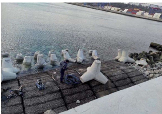
Рисунки 6 ÷ 7 – Кріплення берега акваторії Одеського порту
