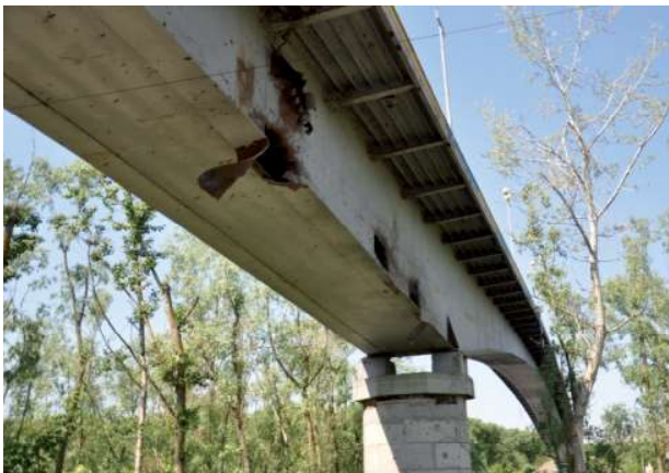
Рисунки 10÷11 – Пробиття і деформування горизонтального та вертикального листів балки прогонової будови № 3-4
