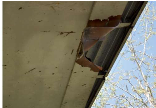
Рисунки 10÷11 – Пробиття і деформування горизонтального та вертикального листів балки прогонової будови № 3-4
