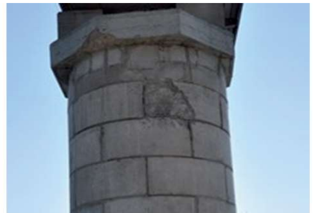
Рисунки 12÷13 – Пошкодження металеві перильного огороження, пробиття мостового полотна на прогонової будови № 3-4 та залізобетонного лицьовального блоку опори № 2
