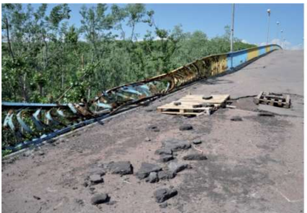
Рисунки 12÷13 – Пошкодження металеві перильного огороження, пробиття мостового полотна на прогонової будови № 3-4 та залізобетонного лицьовального блоку опори № 2
