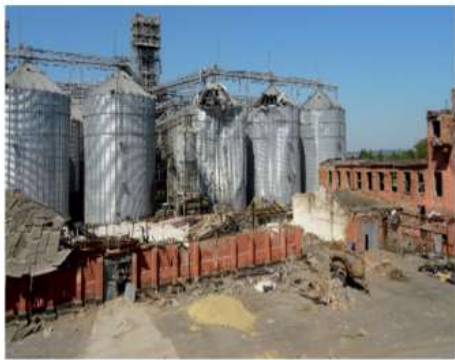
Рисунки 11 ÷ 12 – Руйнація споруд сховищ внаслідок ракетних вибухів
