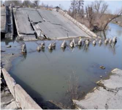
Рисунки 9 ÷ 10 – Руйнація мостової споруди внаслідок артилерійських вибухів
