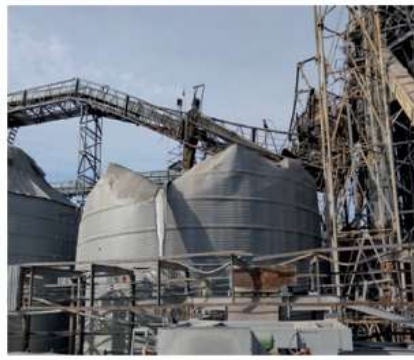
Рисунки 11 ÷ 12 – Руйнація споруд сховищ внаслідок ракетних вибухів
