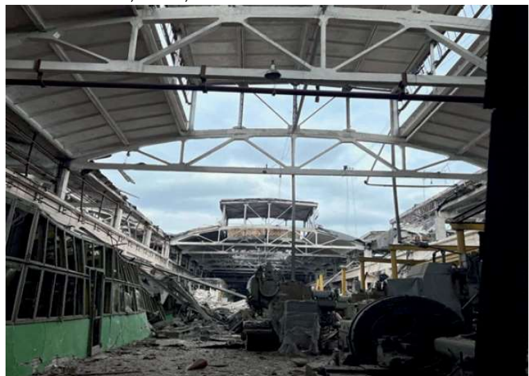
Рисунок 8 – Руїнація промислової будівлі від вибуху ракети
