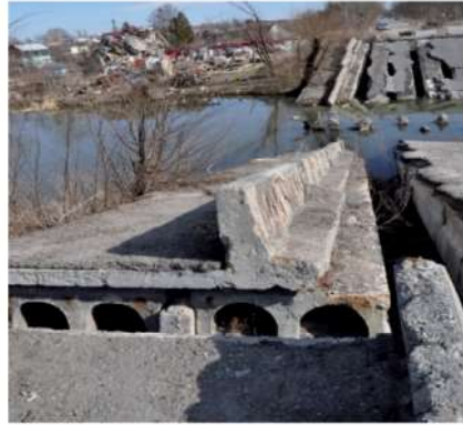
Рисунки 9 ÷ 10 – Руйнація мостової споруди внаслідок артилерійських вибухів
