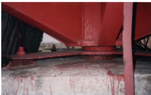
Рисунок 3 – Дефекти опорних вузлів: а – щогли; б – вежі
