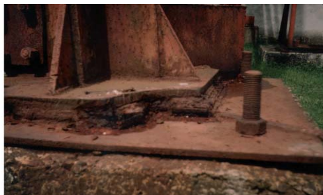
Рисунок 3 – Дефекти опорних вузлів: а – щогли; б – вежі
