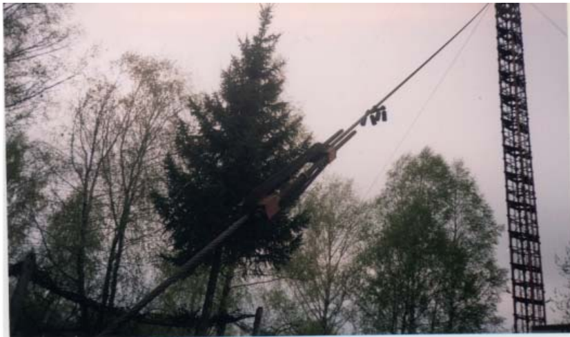
Рисунок 2 – Дефектні нерухомі траверси стяжних муфт
