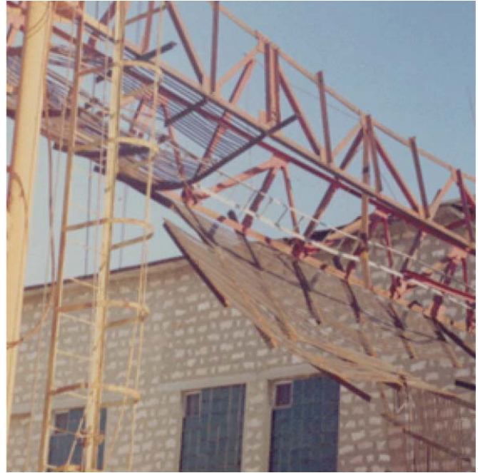
Рисунок 5 – Руйнування конструктивних елементів щогли після падіння крижаної бомби: а – майданчик обслуговування; б – хвилевід і залізобетонне покриття технічної споруди
