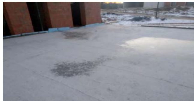
Рисунок 7 – Забетонувана конструкція на 5 добу тверднення
