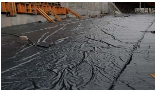
Рисунок 11 – Забетонована конструкція на 2 добу тверднення
