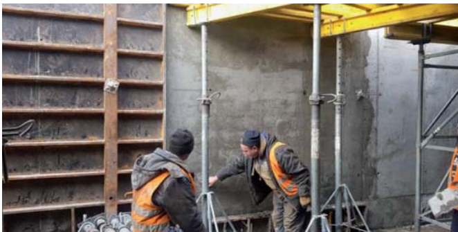
Рисунок 15 – Забетонована конструкція на 2 добу тверднення
