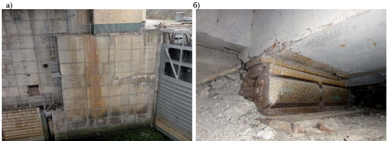
Рисунок 12 – Монолітні залізобетонні опори
