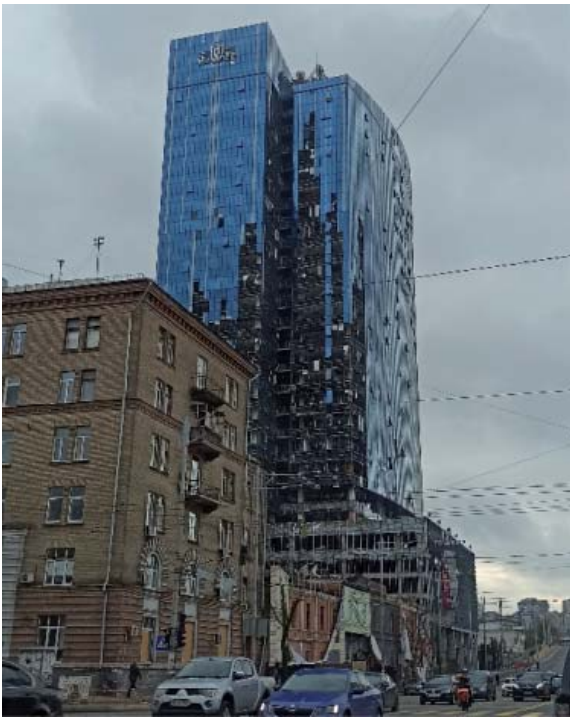
Рисунок 13 – Стан будівлі бізнес-центру «101 Tower» на осінь 2023 р.
