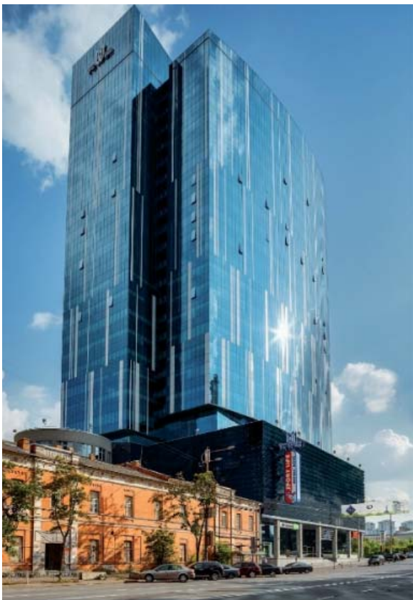
Рисунок 6 – Загальний вигляд будівлі бізнес-центру «101 Tower»
