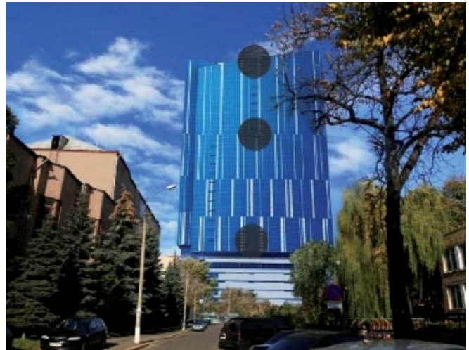
Рисунок 12 – Відбивачі на південно-східному фасаді будівлі
