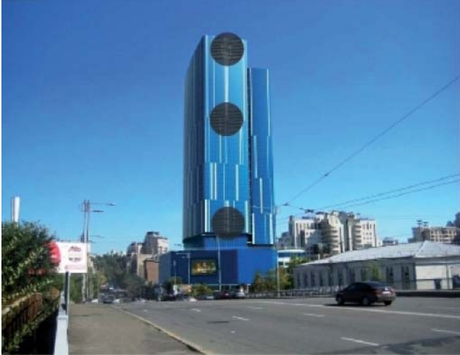
Рисунок 11 – Відбивачі на південно-західному фасаді будівлі
