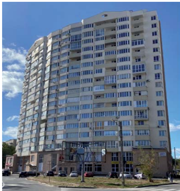
Рисунок 12 – Відновлення часткових пошкоджень житлового будинку по вул. В'ячеслава Чорновола, 15а
