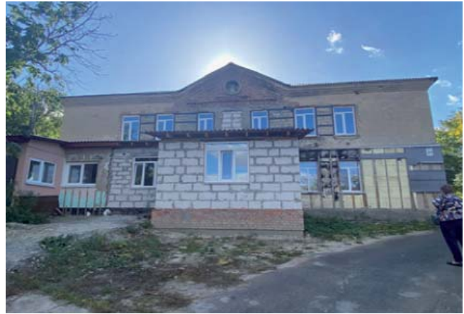
Рисунок 8 – Відновлення часткових пошкоджень житлового будинку по вул. Любецька, 34
