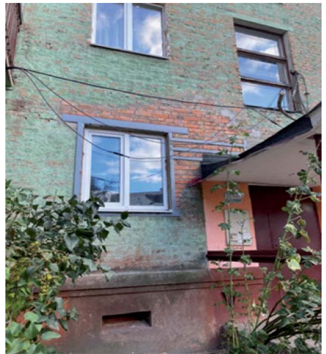
Рисунок 6 – Відновлення локальних пошкоджень житлового будинку по вул. Старобілоуська, 35
