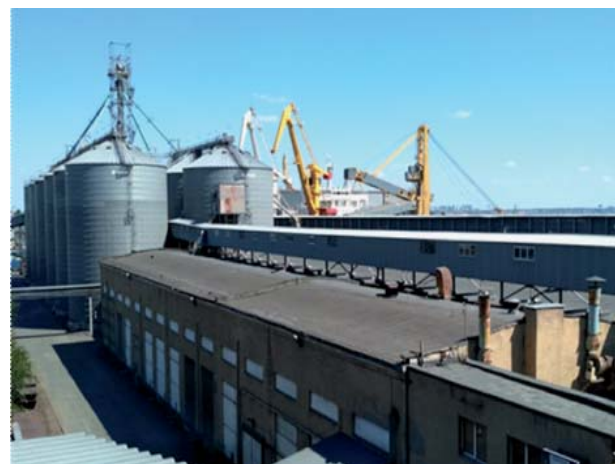
Рисунок 5 – Металеві силоси, склад підлогового зберігання, норійна башта і транспортерні галереї, що входять до складу елеваторного комплексу
