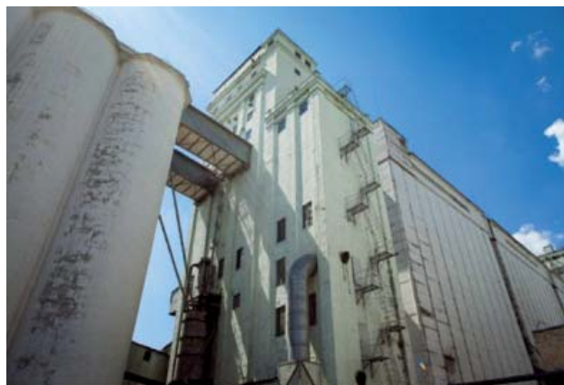
Рисунок 2 – Залізобетонні силоси різної конструкції
