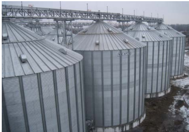
Рисунок 1 – Зблоковані металеві силоси з гофрованою стінкою
