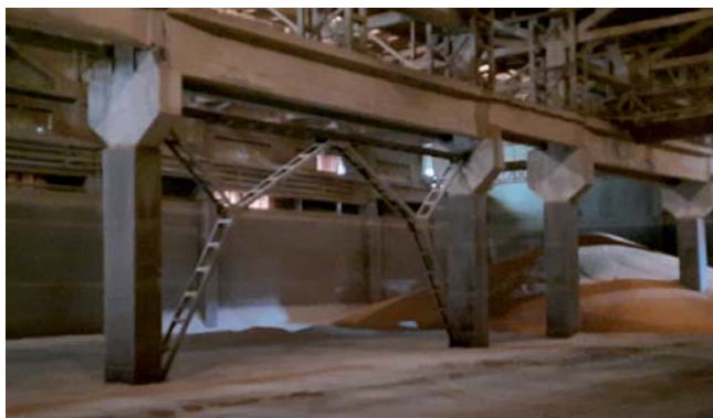
Рисунок 3 – Виробнича будівля, пристосована під склад підлогового зберігання зерна
