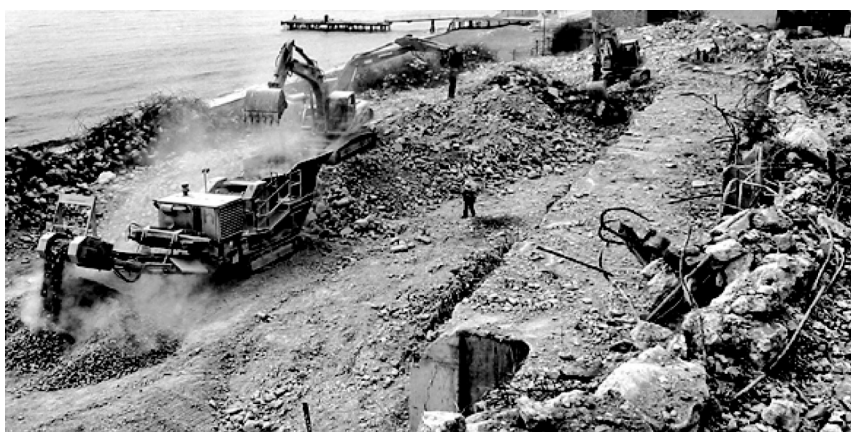
Рисунок 1 – Загальний вигляд комплексу для подрібнення бетону
