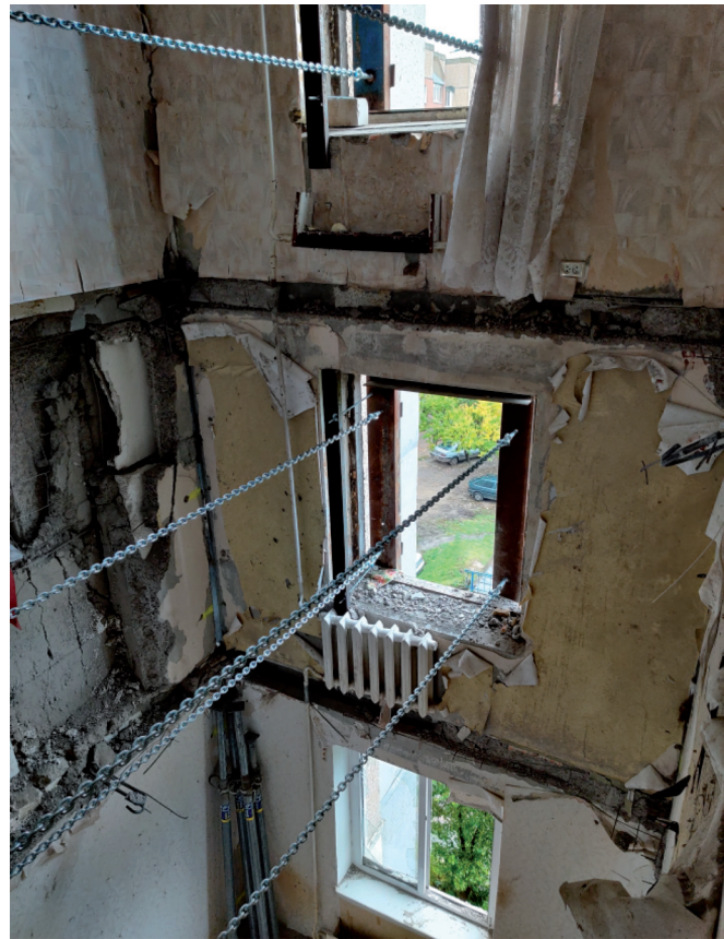
Рисунок 6 – Закріплення фасадних панелей для демонтажу зруйнованих перекриттів
