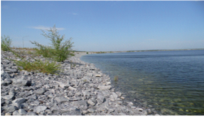
Рисунок 5 – Кріплення верхового та низового укосів огорожувальної дамби верхньої водойми Дністровської ГАЕС
