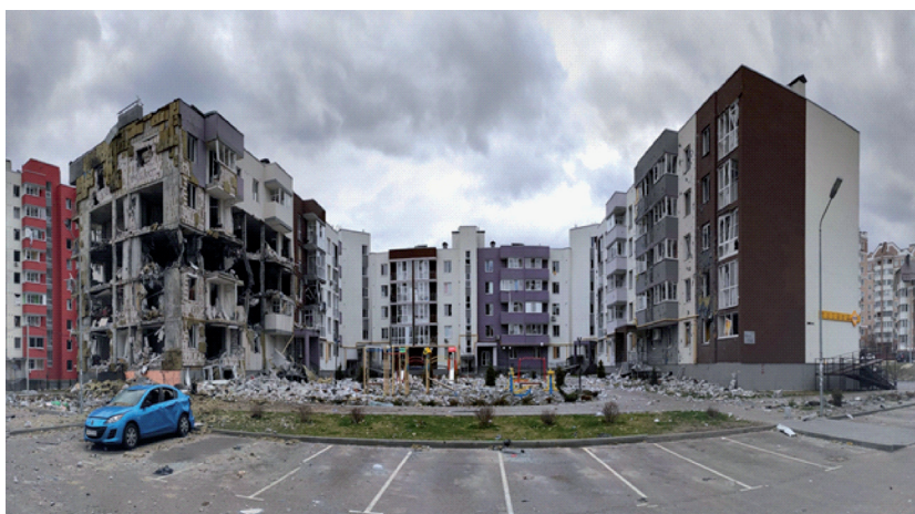
Рисунок 4 – Вид трисекційної житлової будівлі із зруйнованою секцією
