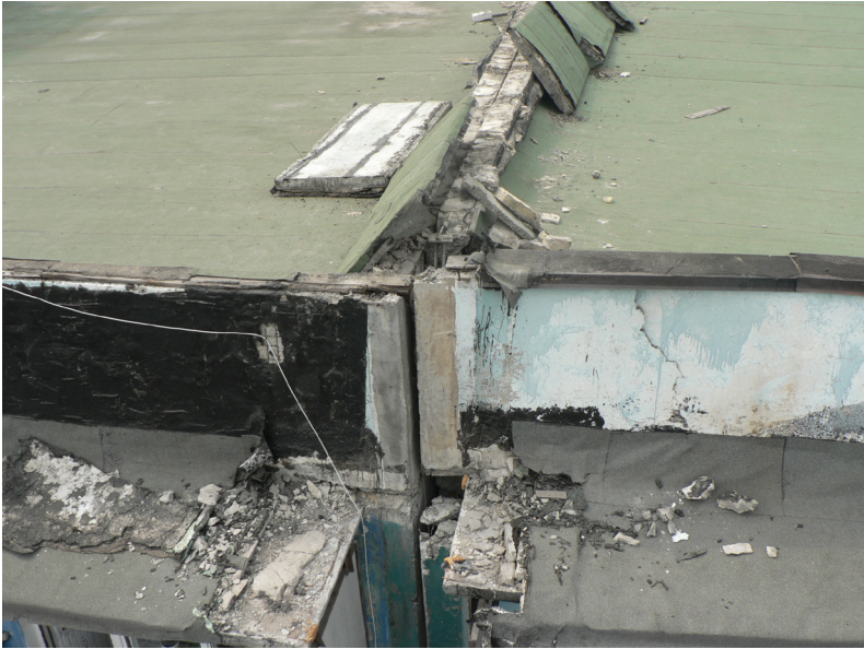
Рис.4. Замикання деформаційного шва між блок-секціями.
