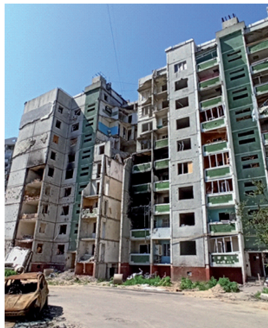
Рисунок 1 – Житловий будинок по вул. В. Чорновола, 15, м. Чернігів
