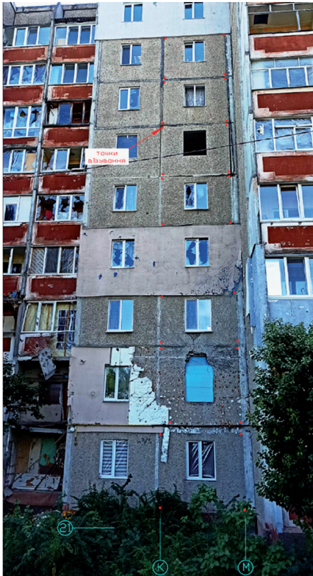
Рисунок 13 – Схема координування панелей житлового будинку по вулиці Белова, 37, м. Чернігів
