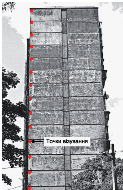
Рисунок 5 – Приклад точок візування по кожному поверху
