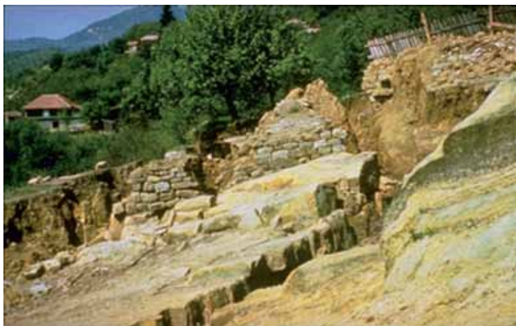
Рисунок 2 – Пример последствия землетрясения в восточных Карпатах, 4 марта 1977 г.: разрушение каменного склона, образование широкой трещины и разрушение домов в посёлке
