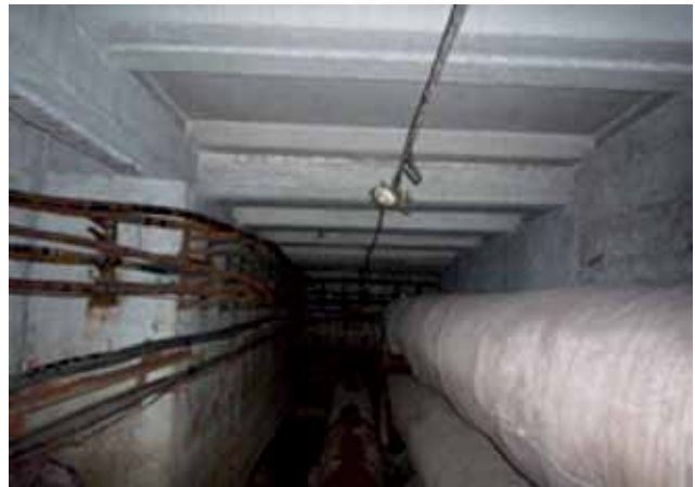
Рисунок 4 - Загальний вигляд тунелю ЧКК
