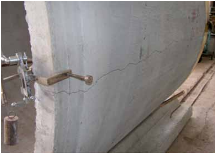
Рисунок 15 - Тріщини на бічній поверхні труби (азимут 90°)
