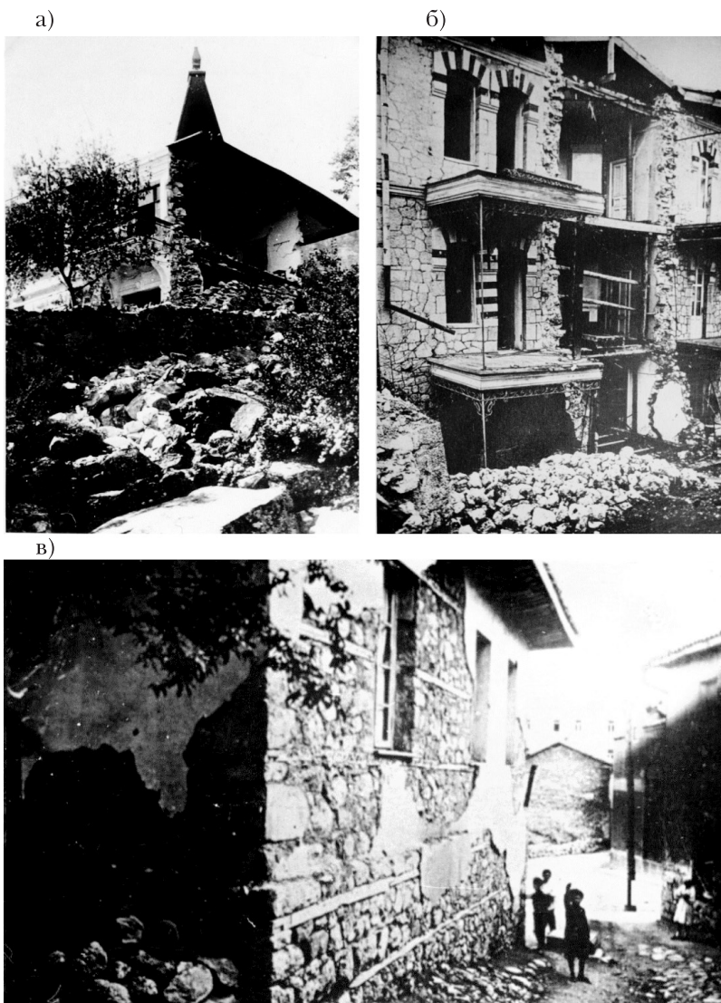
Рисунок 2 – Разрушения зданий при землетрясении 11-12 сентября 1927 г.: а- дача химиков в Рабочем уголке, Алушта; б – дача Б. Смуровой, Алупка; в – одноэтажный дом в Ялте по ул. Елизаветинской (фото из архива Госстроя Украинской ССР)
