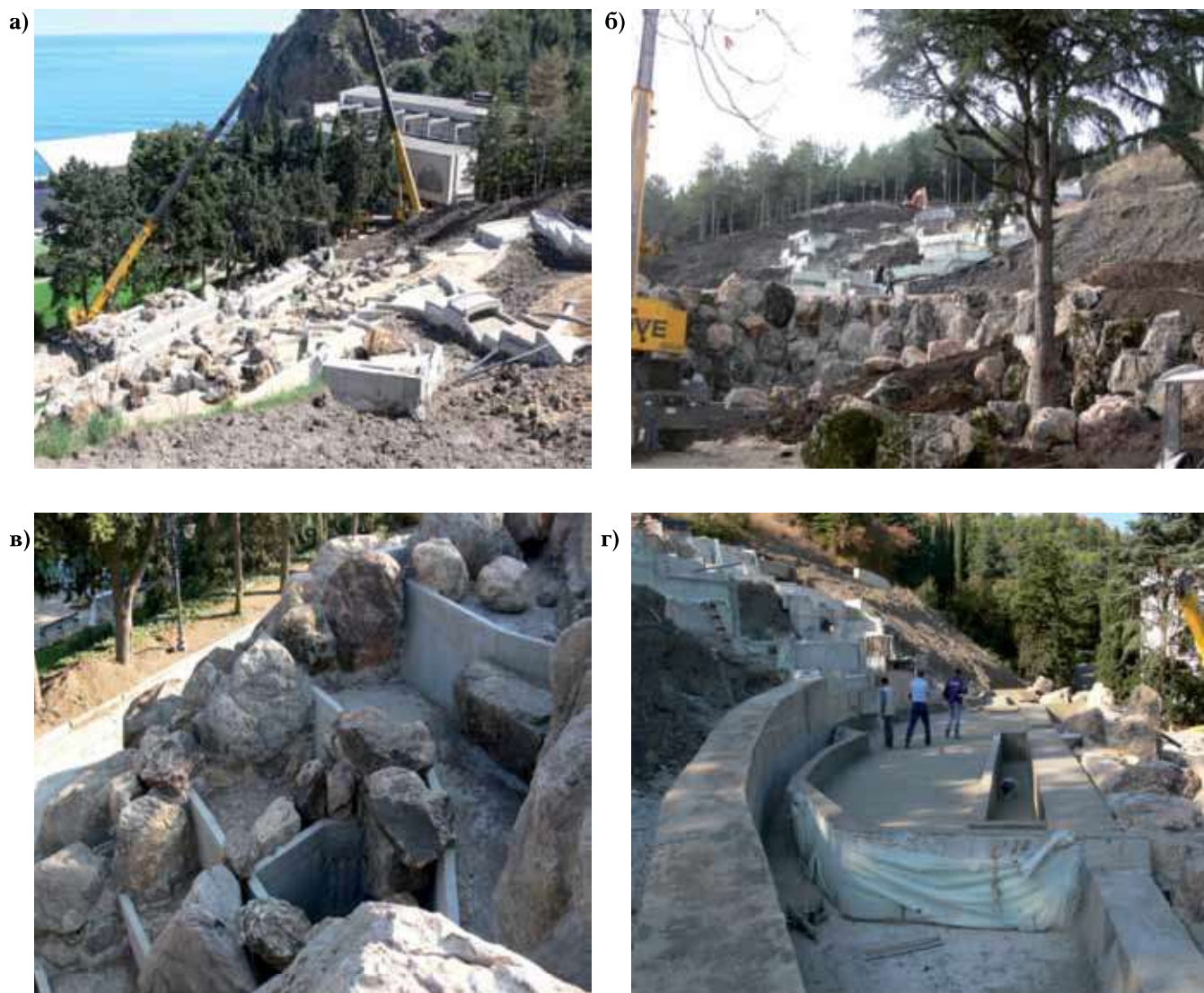
Рисунок 6 – Фотографії різних стадій будівництва (а-г) геотехнічних споруд «Японського саду», що стабілізують локальні зсувні процеси на ділянках схилу зсуву № 75 «Чукурлар-східний»
