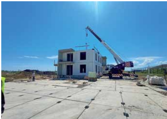
Рисунок 9 - Завершення зведення випробувального фрагменту
